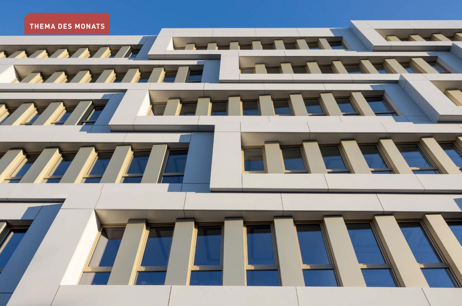
▲ Die Fassadenplatten springen in horizontaler Richtung mehrfach vor und zurück. Dadurch ergibt sich im Grundriss der Fassade eine Art Sägezahn-Muster
