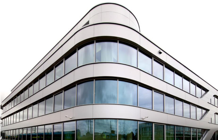
*„Bei diesem Projekt sollte die Fassade keine Gebäudeecken erhalten, sodass wir die Fassade mit gerundeten Platten ausgeführt haben. In diesem Fall wurden die Platten mit einem individuellen Radius gefertigt. Des Weiteren sollten in ausgewählten Rundungen Schweifen vor die Fenster gesetzt werden, die ein besonderes Maß an Genauigkeit der geschweißten Unterkonstruktion erfordert haben.“*
